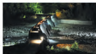
地獄平砂防堰堤ライトアップ
