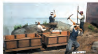
昔の砂防工事の様子(ジオラマ)
