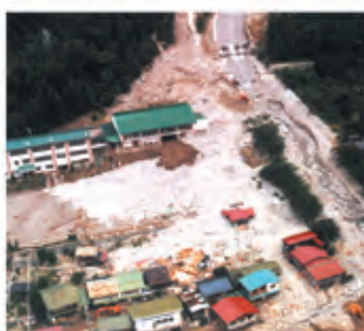
栃尾温泉洞谷土石流災害(昭和54年)
